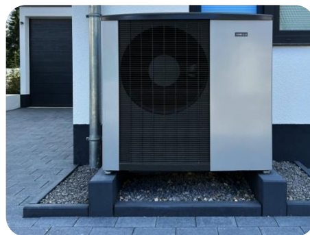
Abbildung 1: Luft-Wasser-Wärmepumpe mit Pumpetechnik im Gebäude (Foto: Trapphagen)
