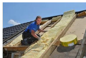
Abbildung 1: Ein Dachdecker isoliert ein Hausdach (Bild: amh)
