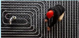
Abbildung 2: Sanitär-Heizung-Klima-Anlagenmechaniker installiert eine Fußbodenheizung (Bild: iStock)
