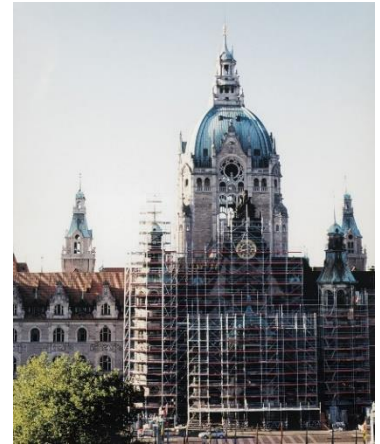
Kirche und Gerüst (© Bundesinnung Gerüstbau)
