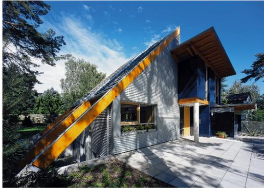
Abbildung 2: Hausdach (Quelle: ZVDH)
