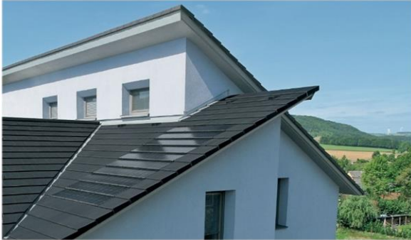
Abbildung 1: Hausdach (Quelle: ZVDH)
