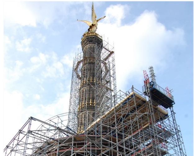
Einrüstung Siegessäule Berlin (© Bundesinnung Gerüstbau)
