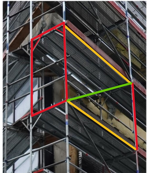
Gerüst an einer Hauswand (© Bundesinnung Gerüstbau)
