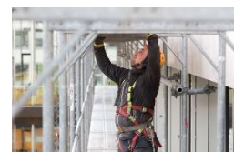
Gerüstbauer auf einem Arbeitsgerüst (© AMH/Falk Heller)
